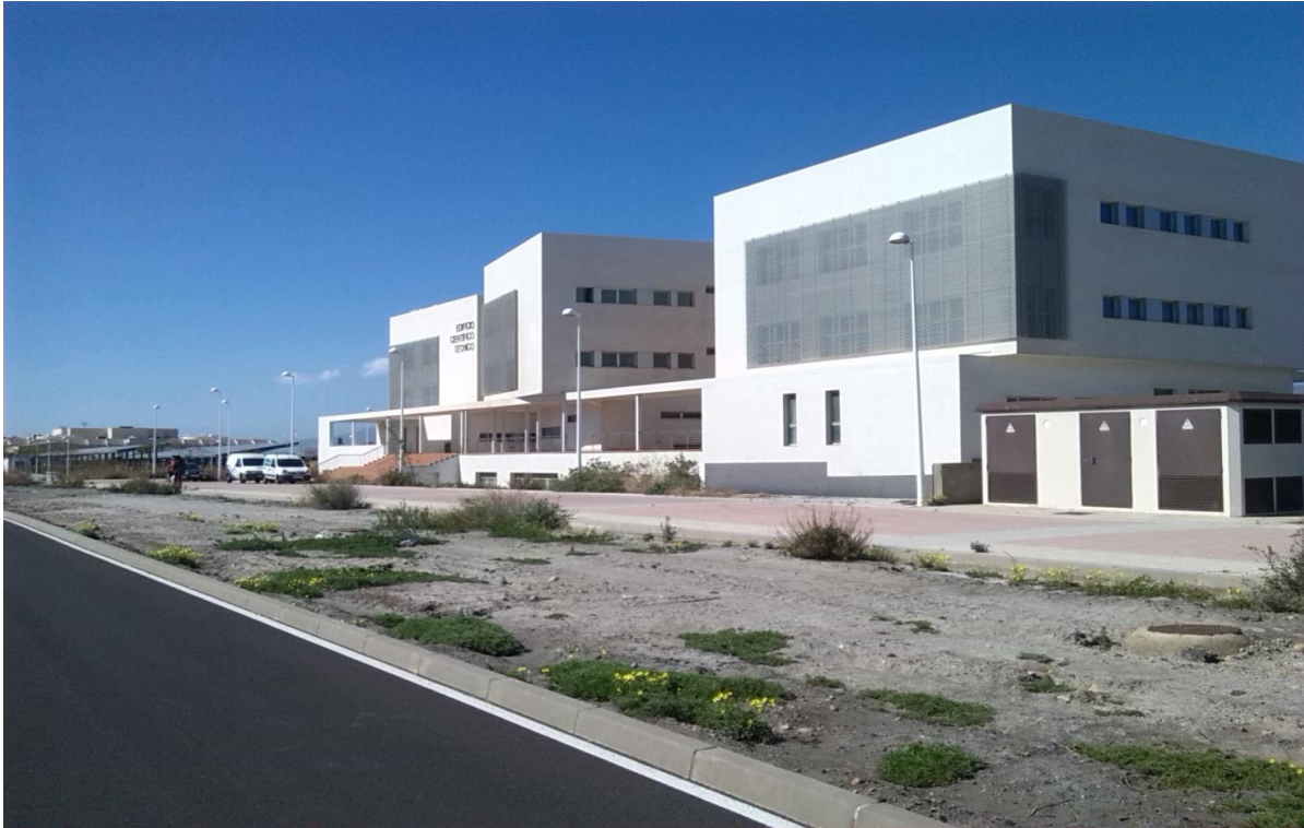
Figura 7. Vista general del estado actual de la parcela de El Jardín de la Sal al sur del Edificio CITE-V.
